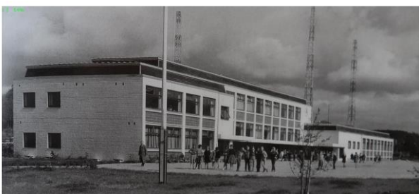
Austrått skole med fløyen som ble bygd i 1957. Bildet er tatt før 1960, da Radiomastene som tyskerne bygde under krigen ennå står. (Kilde Alsвик 2002).
